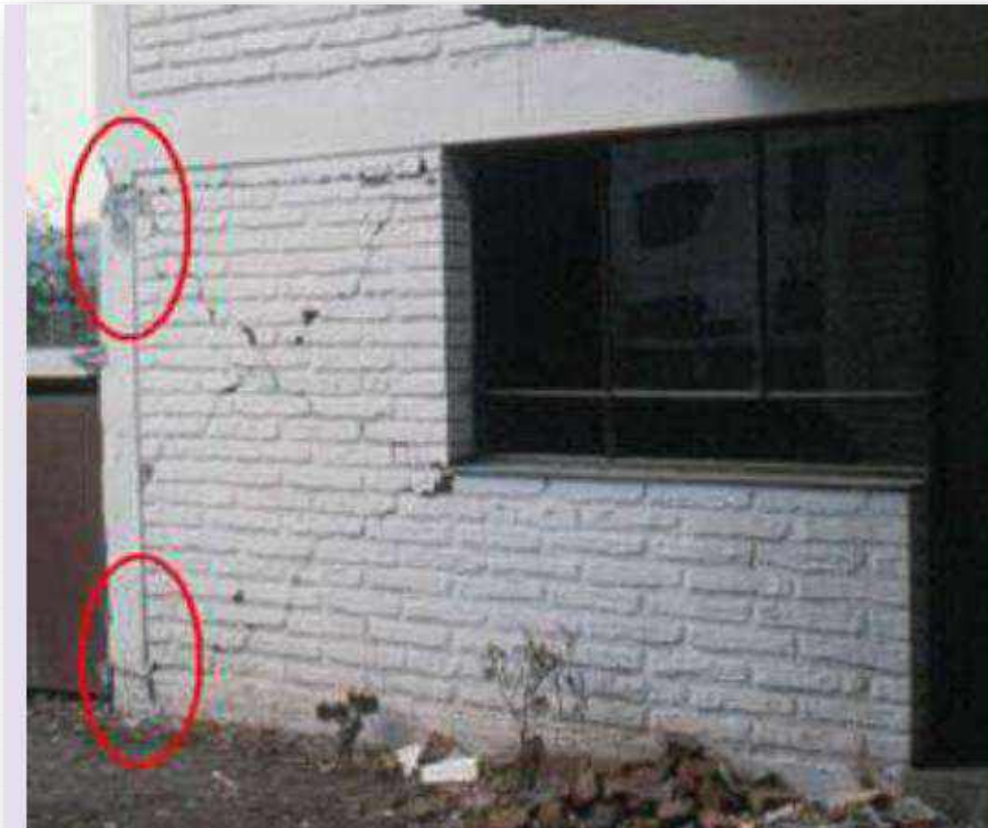
شکست برشی کلاف قائم در دیوار آجری محصور شده
